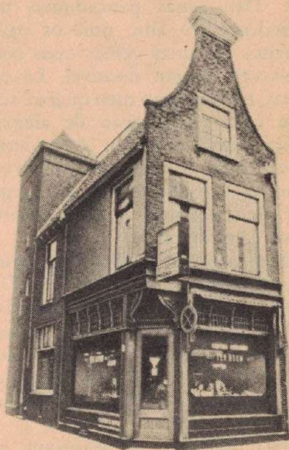
Fachada da casa
